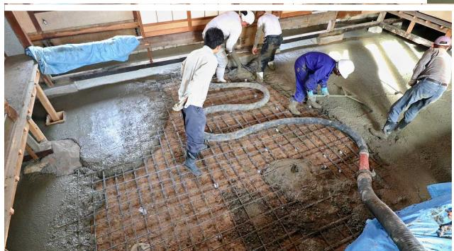
基礎ベース = ピッチ100mmダブル配筋
