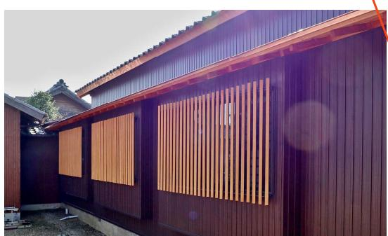
ガルバリウム鋼板外壁 ねじり格子窓枠
