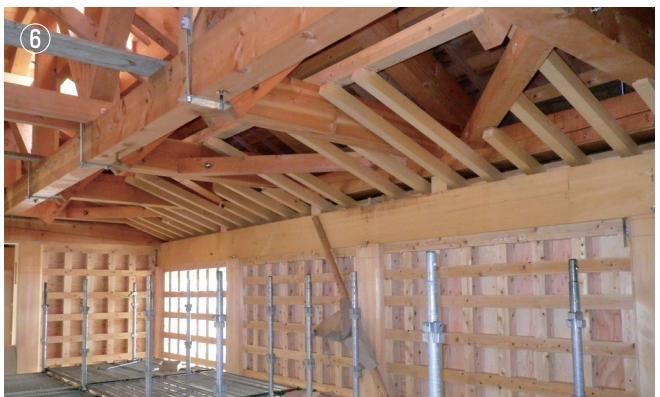
⑥耐力壁＝すべての壁は、斜交いより耐震性に優れた90mm角面格子に12mm厚構造用合板を両面張り。
