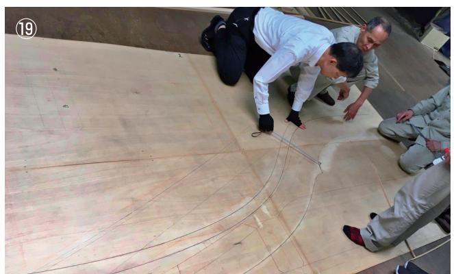
⑰原寸図=唐破風屋根のライン決め風景。
