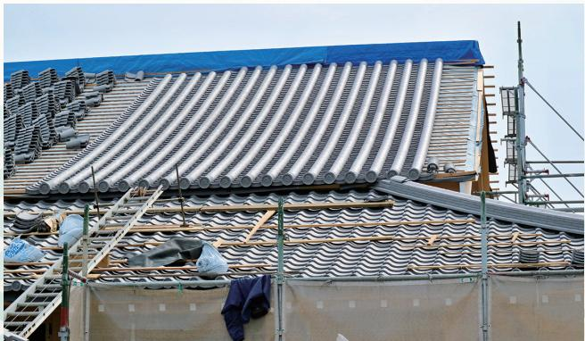
平成30年4月12日 内陣屋根の瓦葺き工事
