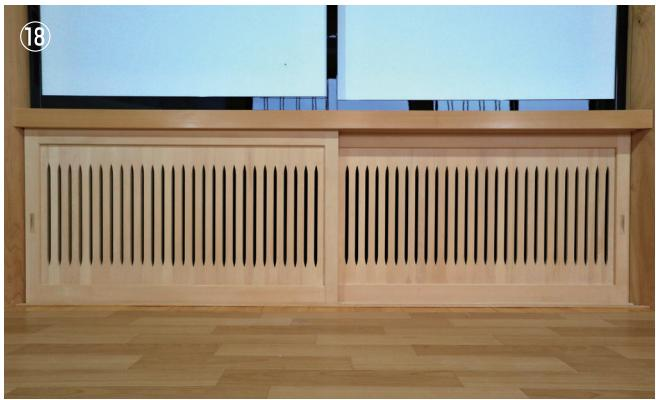
⑯床下換気=夏は冷気、冬は暖気になる床下空気を、堂内に循環させる通風孔を各所に設置。
