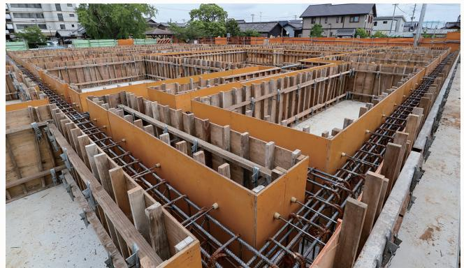
平成29年7月30日 基礎梁型枠工事
