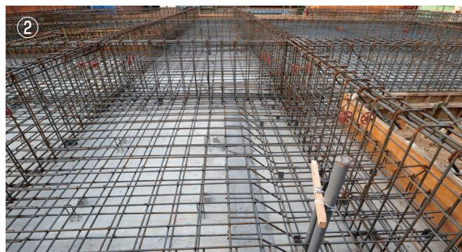
②基礎=配筋ピッチ200mm二重配筋、基礎ベース厚250mm。ただし外周は基礎厚400mm。基礎梁高850mm。総重量約600tの完全一体化した基礎構造体。大きなビルが建つほどの耐力があり、免震機能も有します。
