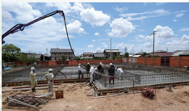
平成29年7月21日 基礎ベースコンクリート打設
