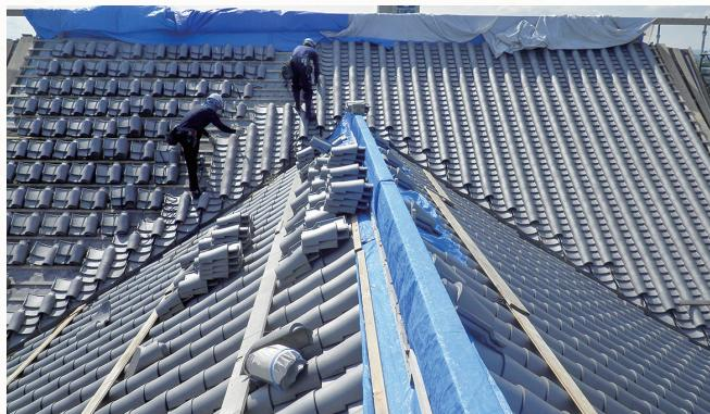
平成30年6月8日 大屋根の瓦葺き工事
