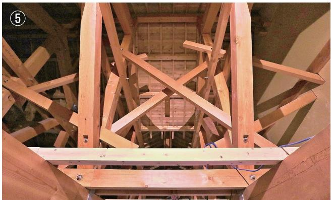
⑤小屋組＝屋根の内部は合掌構造。すべての部材はボルトで固定。右側は防火壁。
