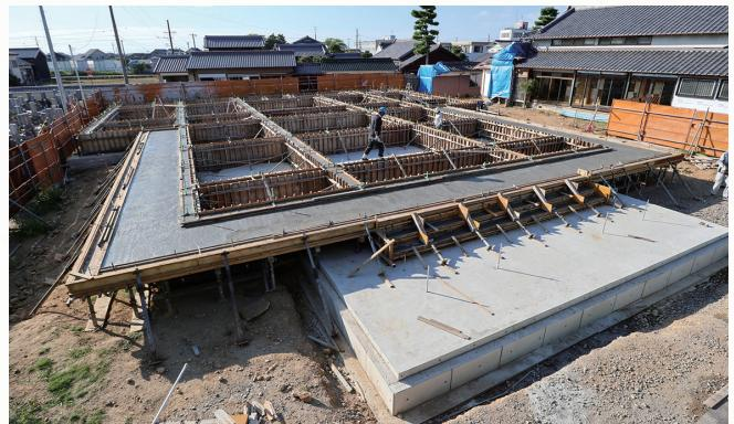
平成29年9月1日 基礎梁と浜縁コンクリート打設
