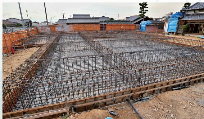
平成29年7月16日 鉄筋の配筋完了
