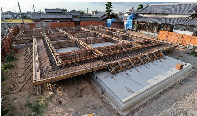
平成29年8月31日 型枠・アンカーボルト等設置完了
