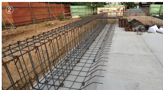
柱状改良の上に150mm厚の碎石コンクリートを転圧して、その上に防湿フィルムと50mm厚の捨てコン施工が終了したところ。ここまででは土壤工事であり、本堂の建築構造物ではありません。
