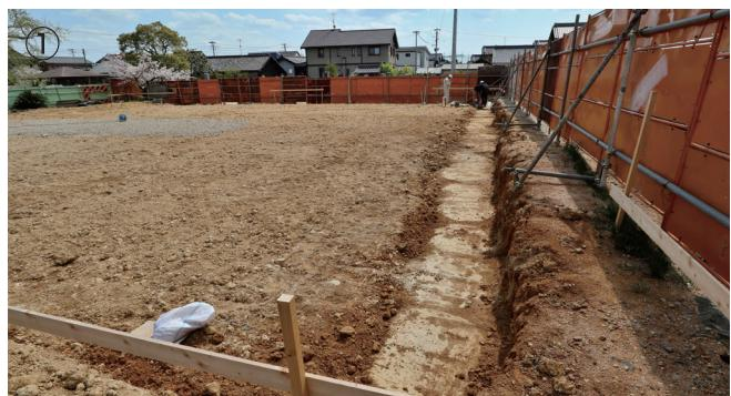
地中コンクリート柱は、直径1.0m×深さ8.0m×181本。1本1.7トン。直径の20%をクロスさせ連壁とし、土中に複数の「箱」を形成。地震時に土壤〔主に砂泥〕を抱え込んで安定させ、液状化を防止。
